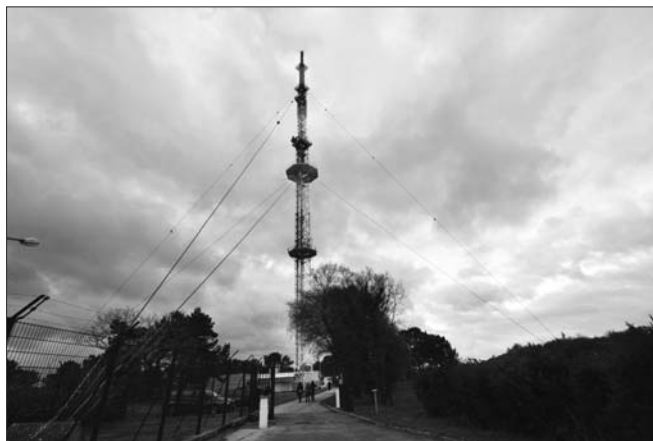
L'émetteur de Digosville, qui permettra aux habitants de cette zone de recevoir la TNT.
